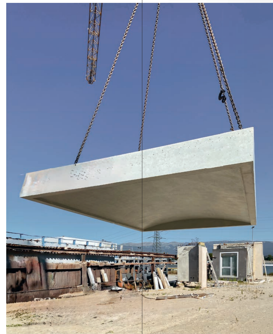
Ci-dessus et ci-contre: vue et coupe de principe du prototype de dalle préfabriquée voûtée en voile mince de 8[cm]. Photo: archives Prelco
