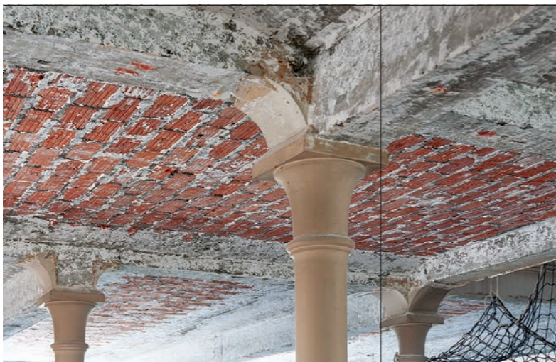
Genève, bâtiment « La Console », l'atrium en cours de rénovation, Henri Juvet, 1902–1904. Restauration meier + associés architectes, Genève, et architech, Aire, 2009–2014. Photo: Didier Jordan
