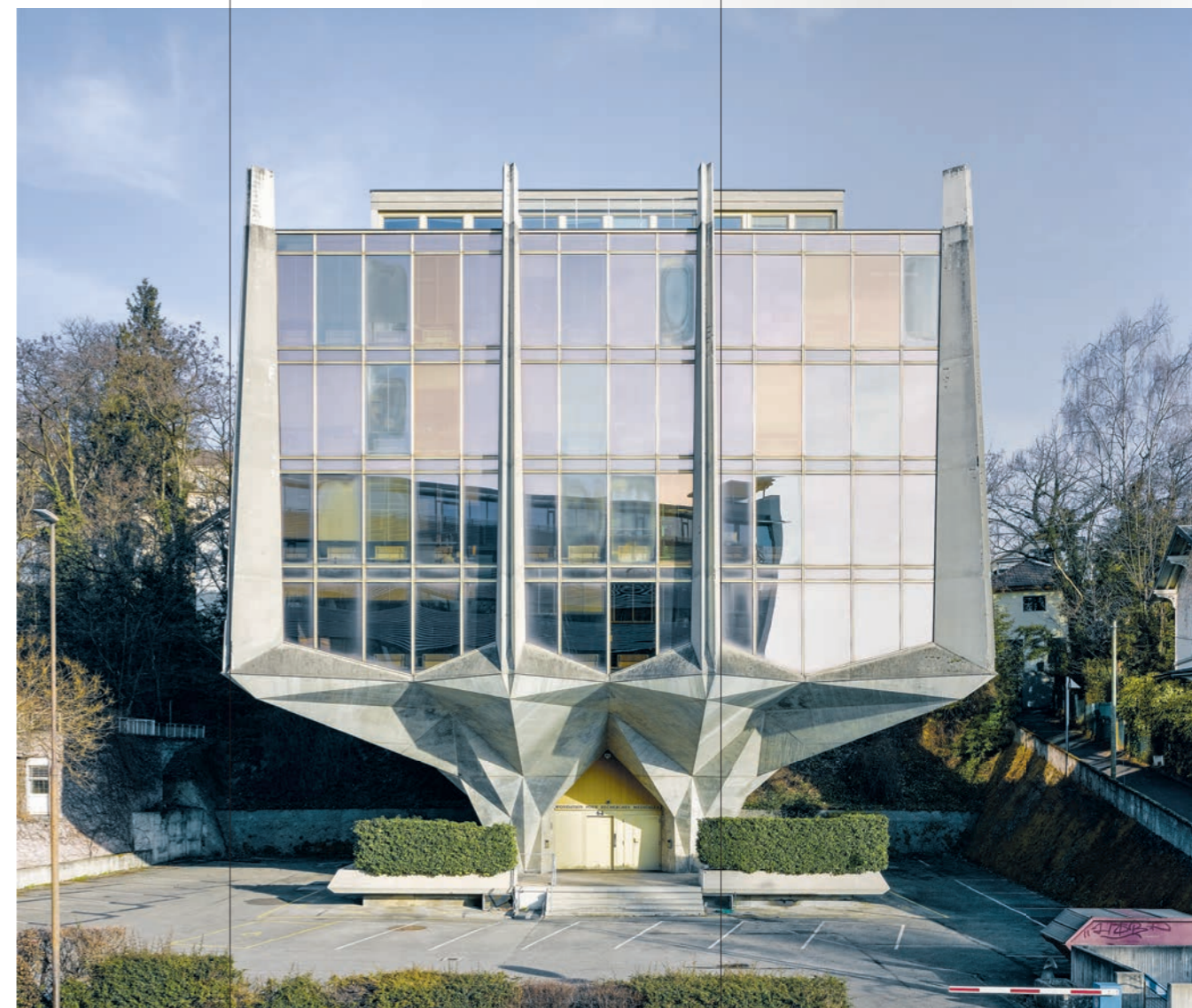
Ci-dessous: Genève, Fondation de recherche médicale de la Faculté de médecine, dite «La Tulipe», Jack Bertoli, 1965-1972. Restauration meier + associés architectes, Genève, 2018, en cours. Photo: Johannes Marburg
