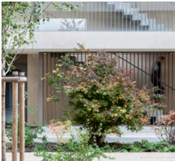
Composition, ou comment le béton s'articule avec d'autres matières pour susciter une émotion. Troinex, quartier résidentiel du Parc des Crêts, Cerutti Architectes SA, Vésenaz; Malnati Architectes Urbanistes, Genève; Trafitec Ingénieurs Conseils, Petit-Lancy; Boccard Parcs et Jardins, Cartigny, 2024. Photo: Hélène Maria
