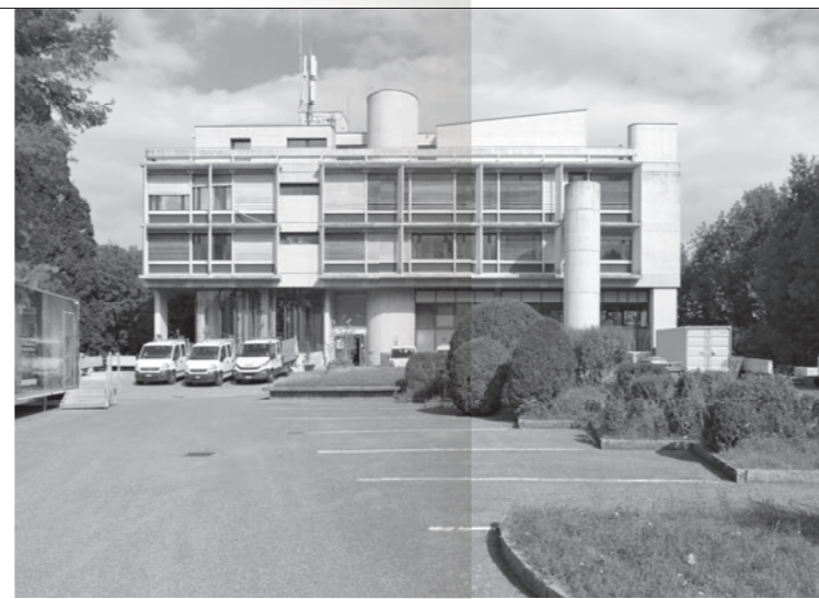
Vernier, STEP d'Aire, bâtiment administratif, dit «La Verseuse», Georges Brera, 1962-1967. Photo: Philippe Meier
