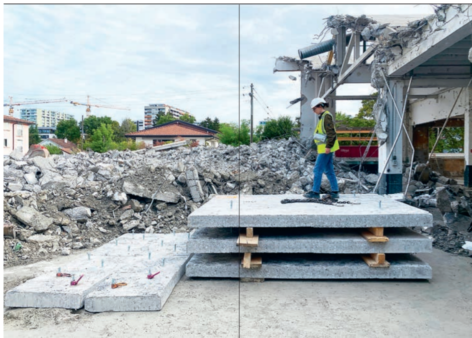
Genève, éléments de dalles en béton prêtes au réemploi et débris de démolition. Photo: Numa Bertola, EPFL, 2023
