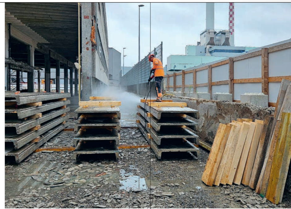
Bâle, parking Lysbüchel, nettoyage des éléments déconstruits. Photo: Maléna Bastien Masse, EPFL, 2024
