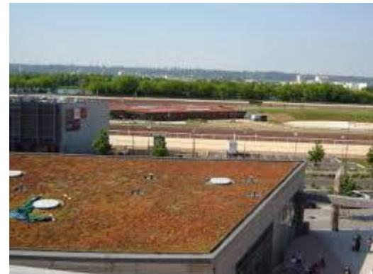
Taxeau : débit régulé à 25 l/s/ha soit une descente pluviale pour 100 m<sup>2</sup> de toiture – à répartir sur le nombre de descentes mises en place
