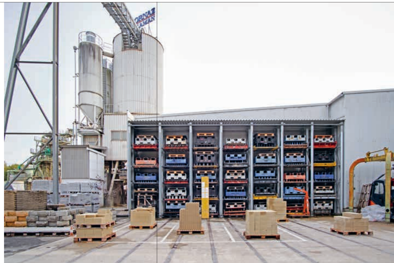
En haut à gauche: Allaman, production en coworking chez Cornaz SA: extraction de terre locale et pression des blocs de terre compressée stabilisée.
