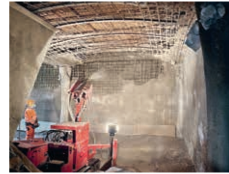
Fig. 1 — Ci-dessus: projection d'un mur en shot-earth
