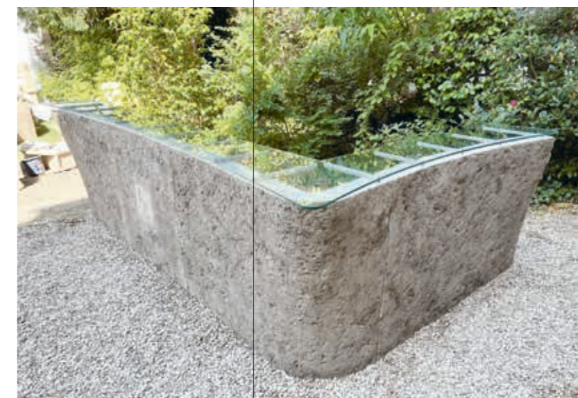
Fig. 5 — Paris, Ambassade de Suisse. Bar extérieur à double courbure en shot-earth réalisé pour les Jeux Olympiques, 2024. Photo: Sébastien Pittet
