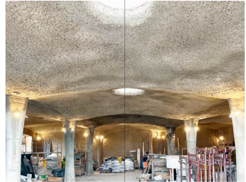
Fig. 2 — À droite: Ursy, parc Catalan dont la toiture est constituée de voûtes en shot-earth armé (rayon des voûtes de 6 m, oculus de 0,9 m)
