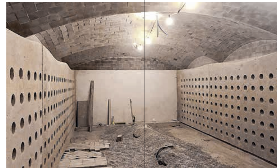
Fig. 4 — Cave à vin en shot-earth où les voûtes catalanes à double courbure et le sol sont respectivement réalisés en Ecorasillas (briques en terre d'excavation crue, 2 cm d'épaisseur) et en briques en terre d'excavation crue (8 cm d'épaisseur). Photo: Sébastien Pittet
