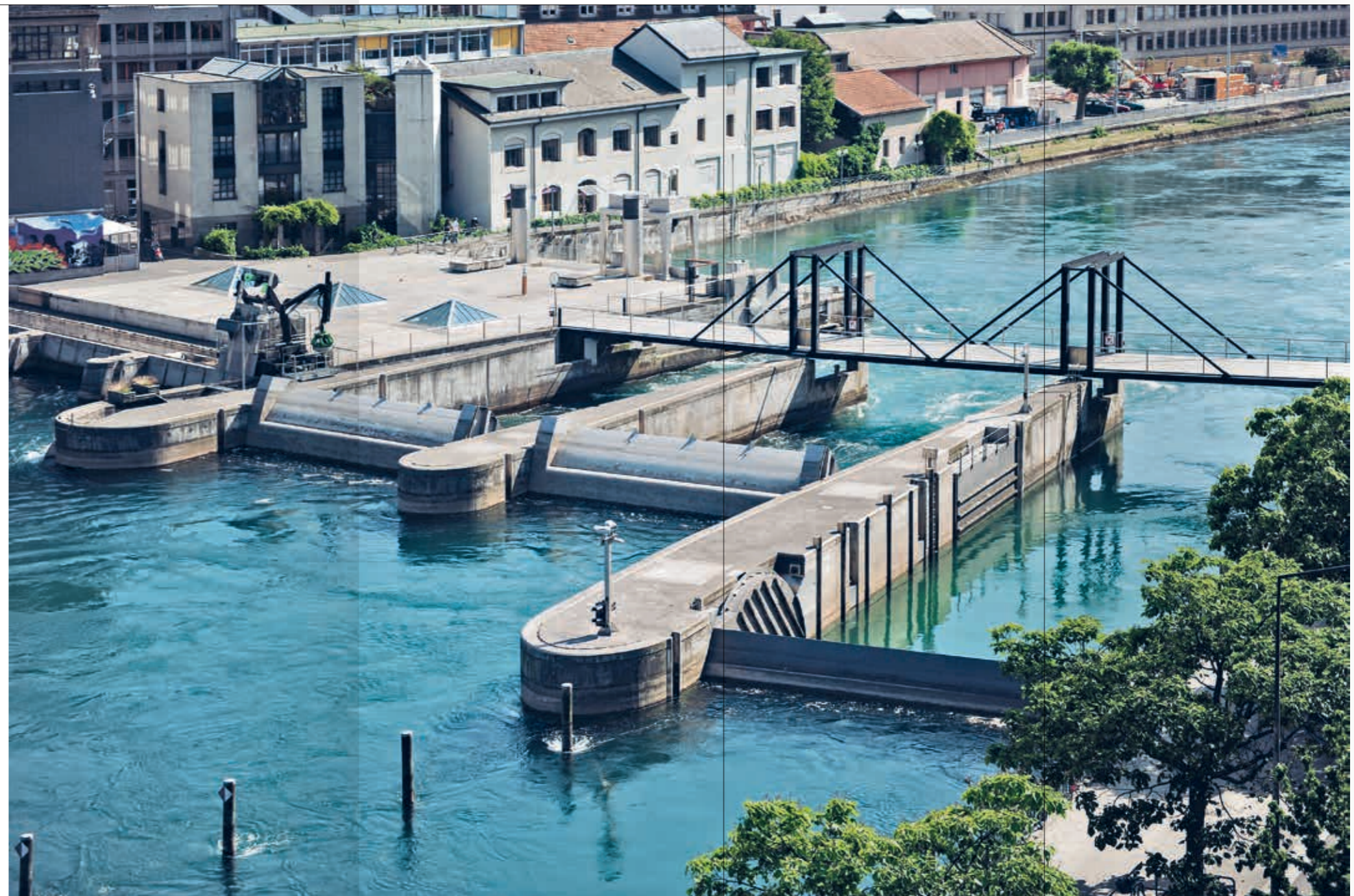
Barrage du Seujet, 1987-1995. Photo: Jay Louvion, 2010
