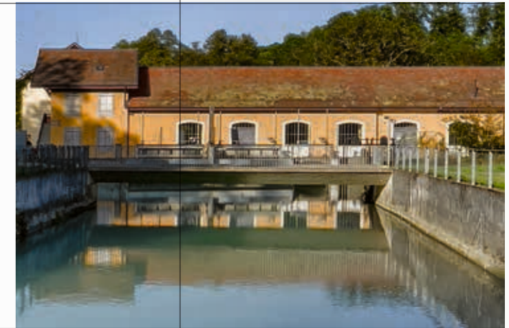
Barrage de Vessy, 1865. Photo: Daniel Kunzi, 2023
