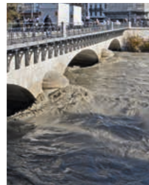
Barrages et production hydraulique à Genève. Photo: Daniel Kunzi
