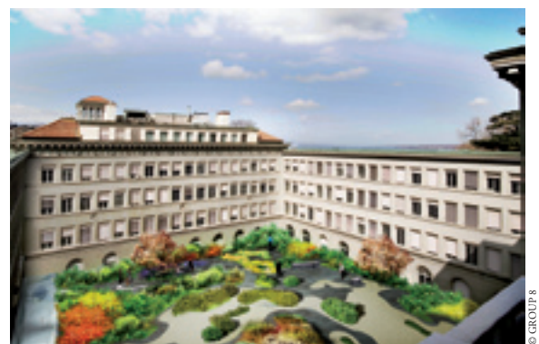
Rénovation du Centre William Rappard (OMC) par Group8, Genève.
