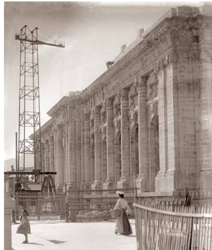
Rue Charles-Galland, le Musée d'art et d'histoire en construction, façade principale, vers 1907.
